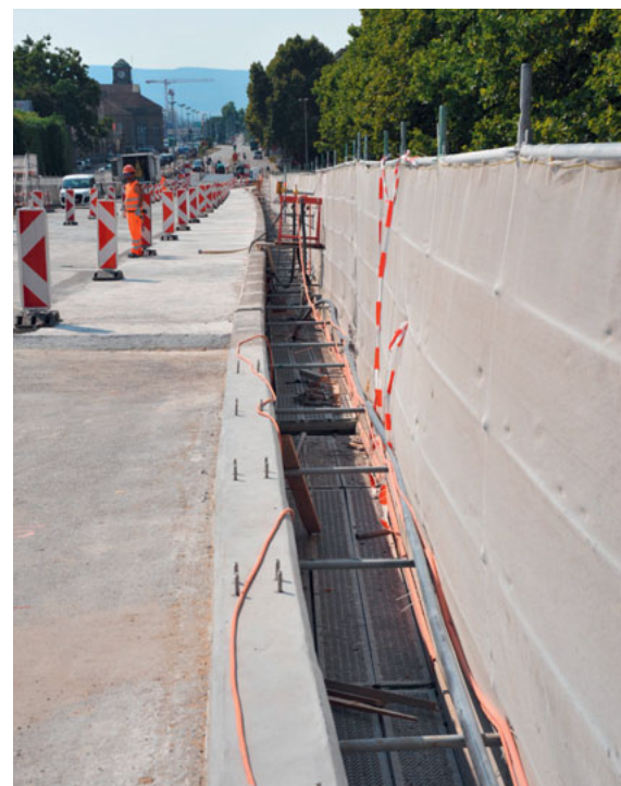
Die Betoninstandsetzung umfasst Unter- und Aufsicht, die Widerlagerwände und Stützmauern.
