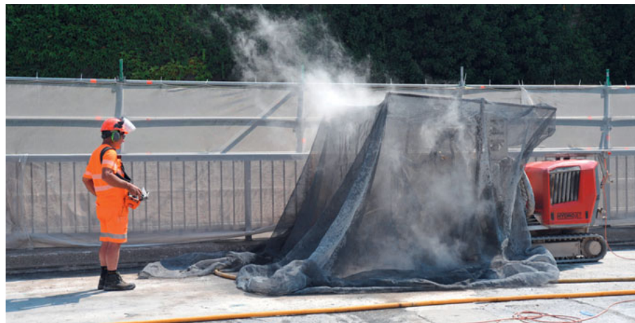
Dank dem schönen Sommer befinden sich die Sanierungsarbeiten alle im Terminplan.
