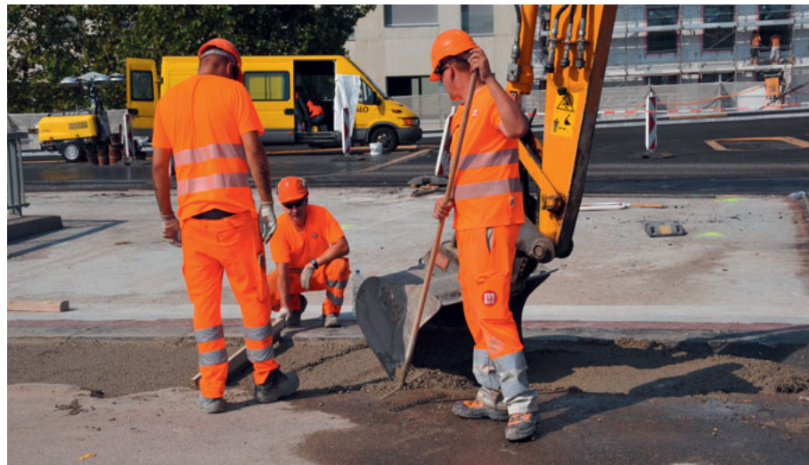
Fahrbahnplatten, Brückenplatten, Stege, Hohlkästen und Gerbergelenke werden allesamt instand gesetzt.
