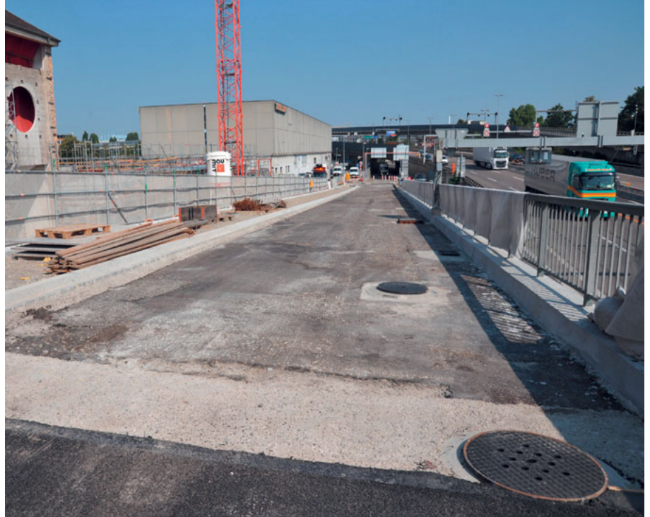
Zu den Autobahnbrücken gehören auch verschiedene Auf- und Abfahrampen.
